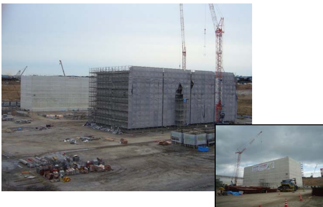
【進水前のハイリッドケーソン全景(H25.12.17撮影)】
