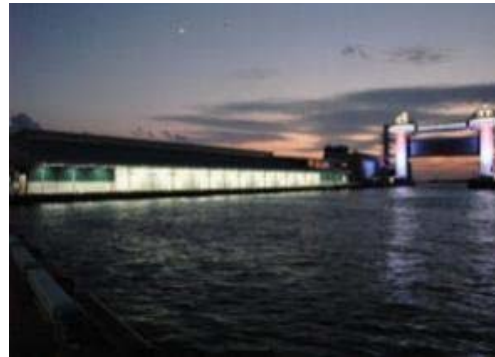
大型展望水門「びゅうお」のライトアップ (沼津港:みなとオアシス沼津)
