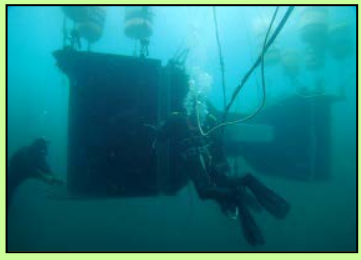
鋼製補強材設置
