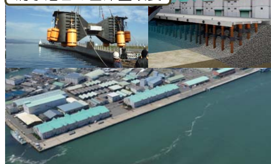
清水港日の出岸壁改良
