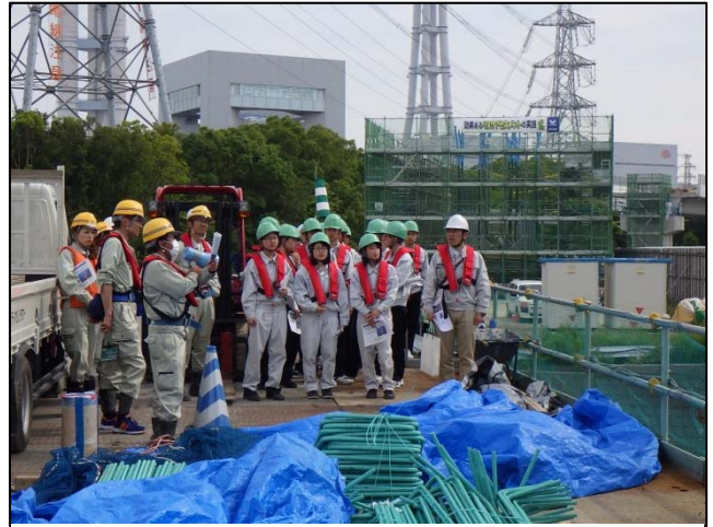
現地での工事説明
