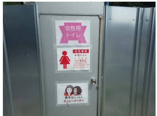
現場に設置された女性用トイレ
