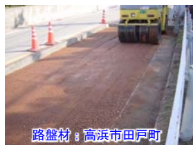
路盤材 : 高浜市田戸町
