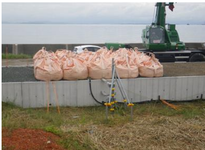
写真 1.1 現地載荷状況写真
