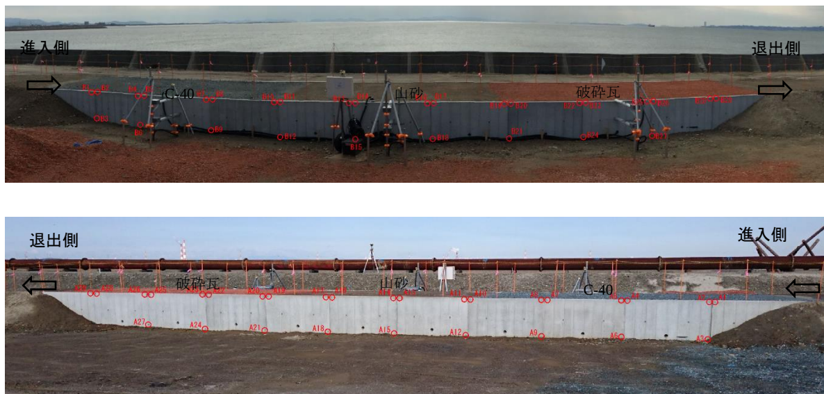
図 1.16 L 型擁壁側面部の測点位置図
