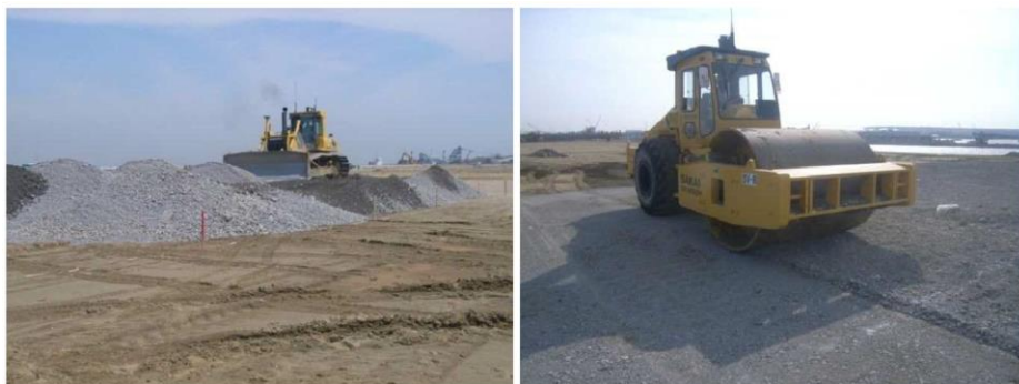
④敷き均しおよび転圧
