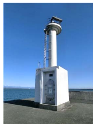
完成 イメージ (御前崎港防波堤 B 灯台)
