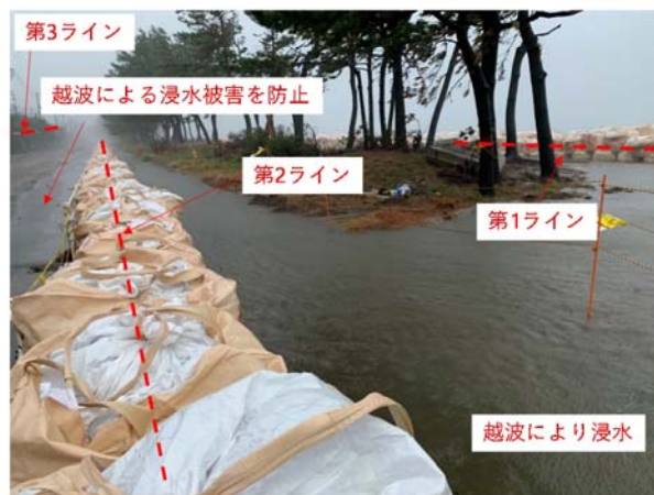
土のうを3列に配置し浸水被害を防止 (10月12日撮影)
